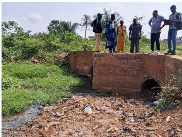
Planche 2 : Illustration des zones d'inondation liée au mauvais écoulement des eaux sous les rails
