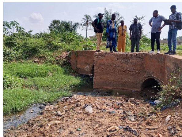
Planche 2 : Illustration des zones d'inondation liée au mauvais écoulement des eaux sous les rails
