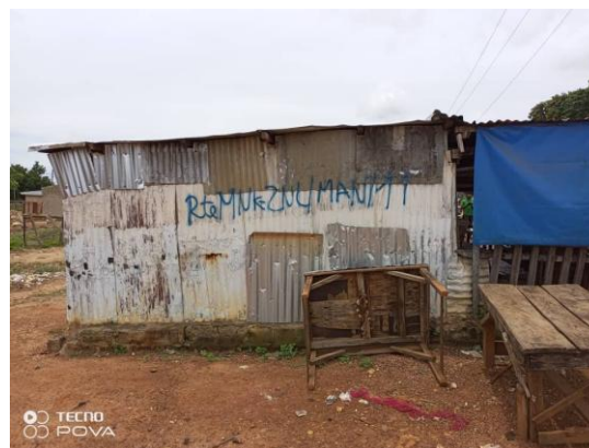
Photo 68: Vue d'un bâti dans l'emprise du projet à Mankono
