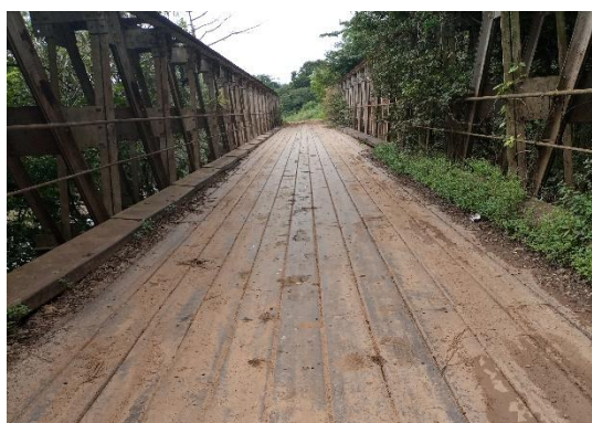
Photo 11 : Aperçu du pont sur la Marahoué Zuénoula et
