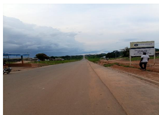
Photo 16 : Aperçu de la voie bitumée de Oussougoula vers Mankono
