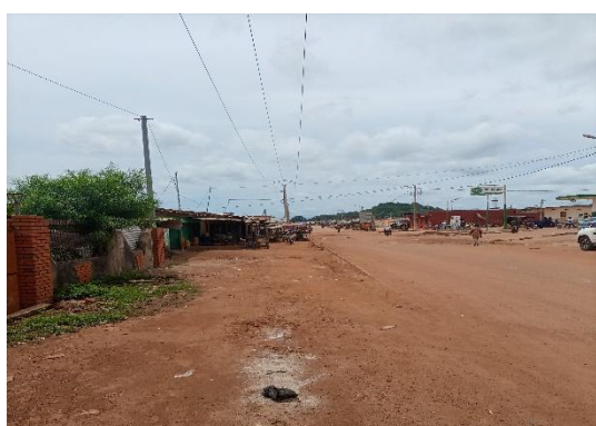
Photo 15 : Aperçu de la ligne moyenne tension bordant la voie à élargir à Mankono
