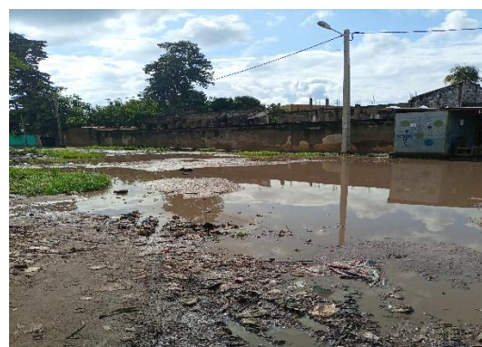
Photo 8 : Problème d’assainissement juste avant le carrefour du marché à Zuénoula
