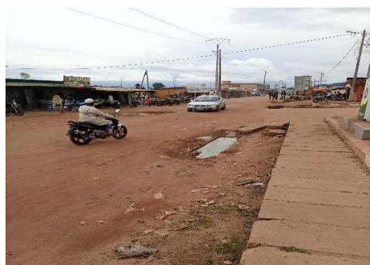
Photo 13 : Aperçu de la voie principale à élargir au niveau de Mankono
