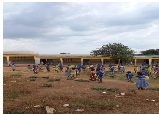
Photo 56 : Aperçu de l'école primaire de Bohizra
