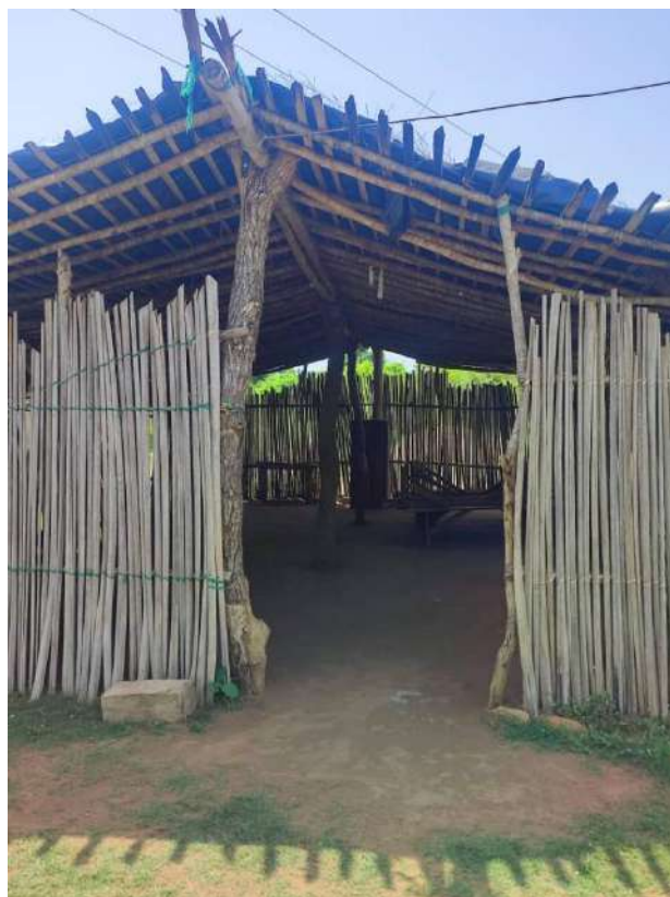
Photo 22: Eglise construite en Bois (X : 7.816719 ; Y :-6.082647)...
