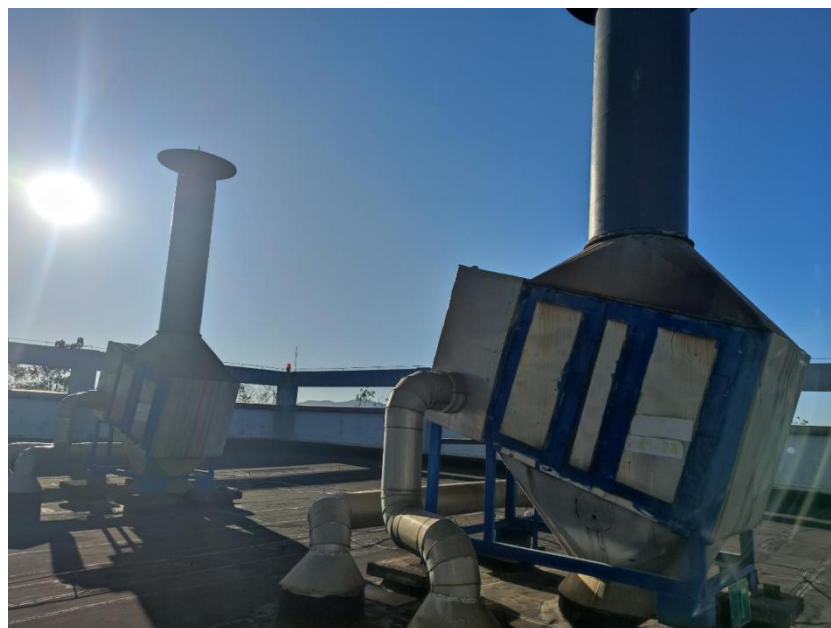
图 11 燃气锅炉的烟囱
