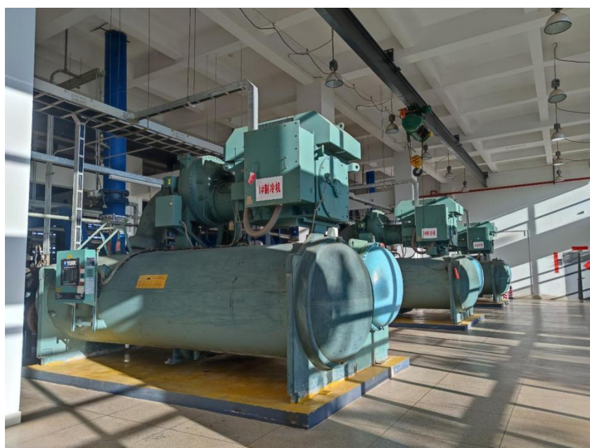
图 12 动力能源中心的冷水机组
