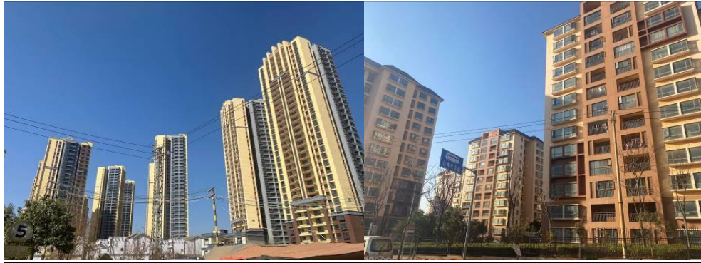
图 E-1 安置小区现状照片
