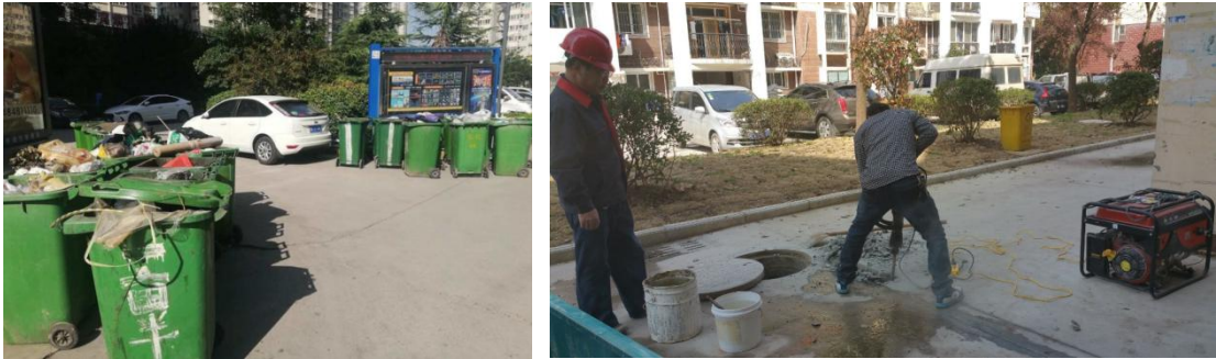
图 14-7 社区垃圾处理与水管维修
