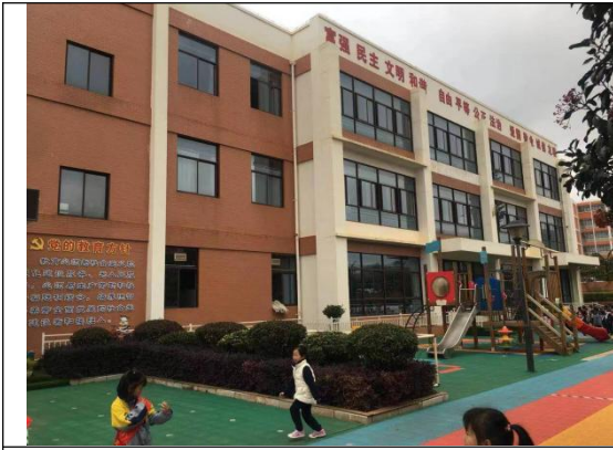
昆明空港经济区第一幼儿园（已安装隔声措施）
