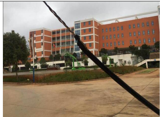
昆明空港第一小学（已安装隔声措施）
