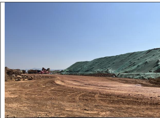
建设施工现场
