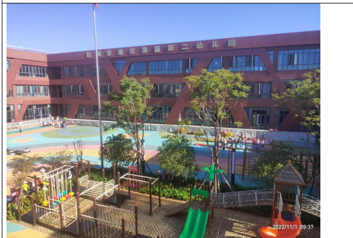
昆明空港经济区第二幼儿园（已安装隔声窗）
