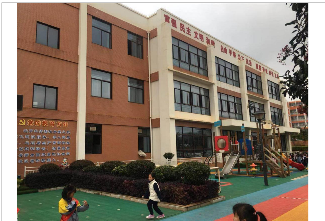
昆明空港经济区第一幼儿园（已安装隔声窗）
