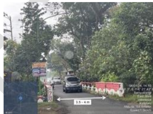
(d) Bridge condition at Joyoboyo Road
