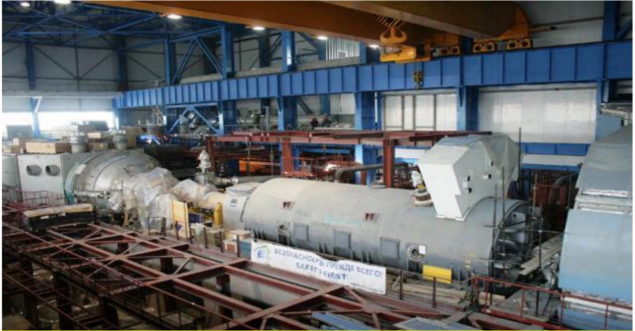
Расм 7: Қуввати 1600 МВт бўлган комбинацияланган цикли газ турбинасининг намунаси
