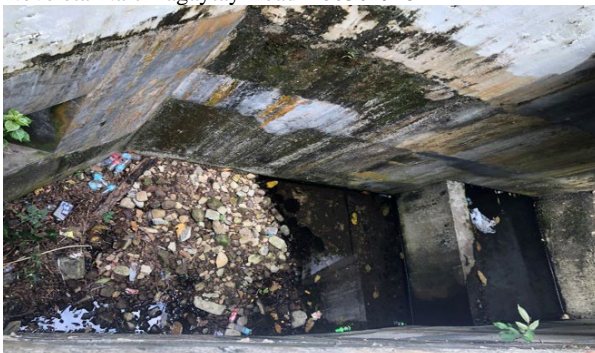
Nasugbu Road K0070+000 (Kaybiang Tunnel)
