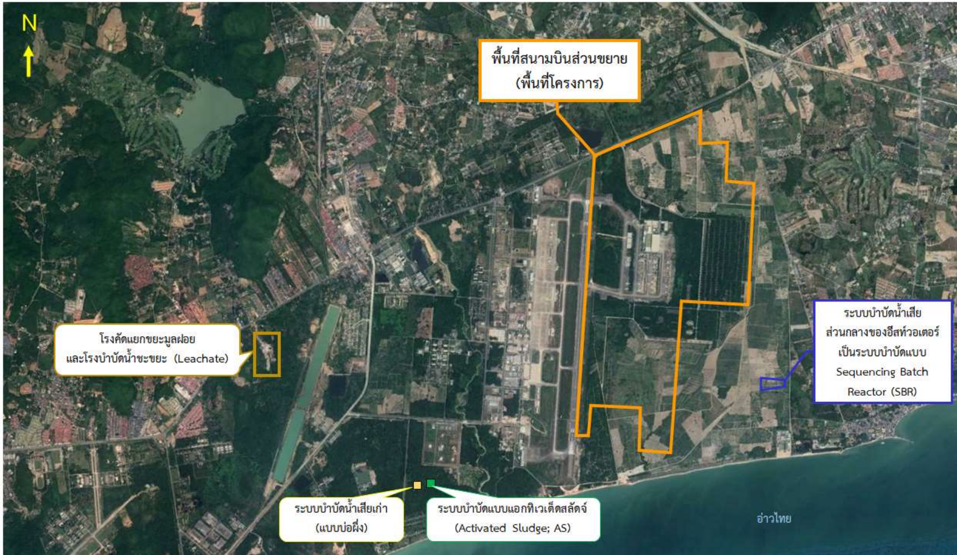
รูปที่ 3.7-3 ตำแหน่งระบบบำบัดน้ำเสียแบบบ่อฝิ่ง (ที่ใช้งานไม่ได้) ระบบบำบัดน้ำเสียแบบแอกทีเวเต็ดสลัดจ์ (Activated Sludge; AS) ที่ใช้งานอยู่ในปัจจุบัน โรงคั้ดแยกขยะและโรงบำบัดน้ำชะขยะ (Leachate)
