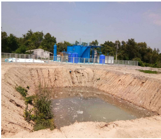
(ง) บ่อรองรับน้ำทิ้ง
