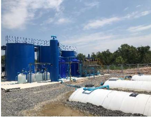
(ก) ระบบบำบัดน้ำเสียแบบแอกทิเวเต็ดสลัดจ์ (AS)
