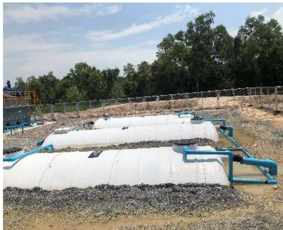
(ค) ถังเติมอากาศ
