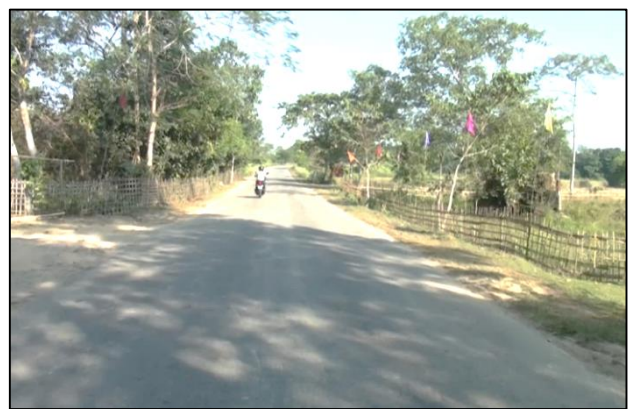
End Point (Kamarbandha) at Chainage 42+094
