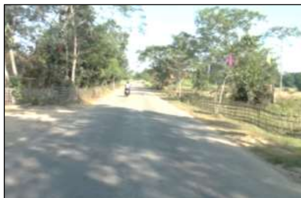
End Point (Kamarbandha) at Chainage 42+094
