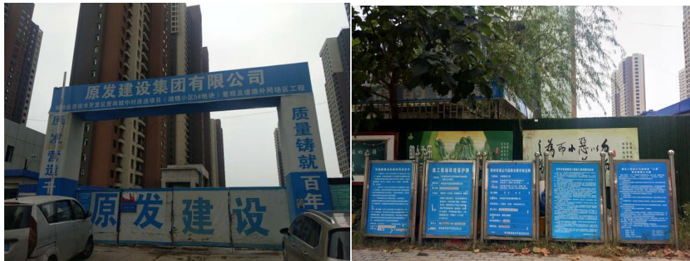
图 4-3 安置小区施工现场图
