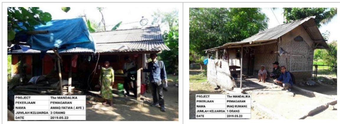
Gambar 5-1 Contoh Kondisi Rumah Warga Terdampak Proyek
